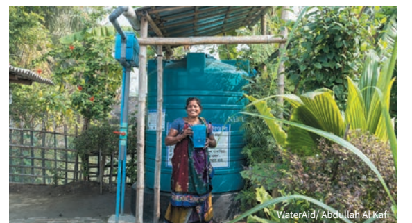
雨水貯留タンクの設置により、乾期の間も安全な水を利用することができる (バングラデシュ)
