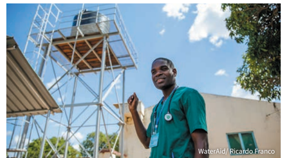
保健医療施設に設置した給水システム (モザンビーク)
