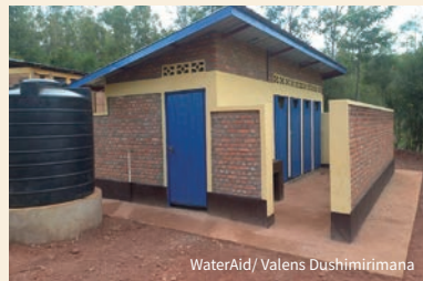
保健医療施設に設置したトイレ棟
