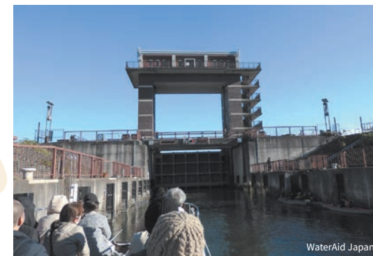
墨田区水の循環講座 荒川ロックゲートを通航
