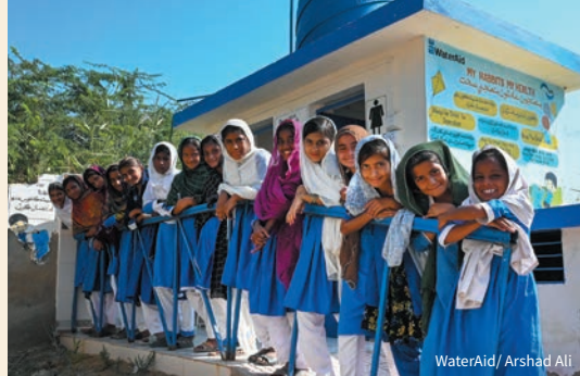
学校に新設した給水・衛生設備
